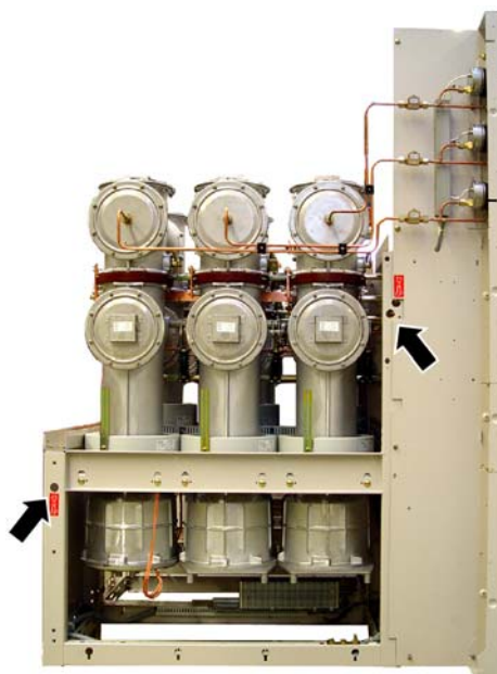
Рисунок 29: Положение транспортировочных отверстий
