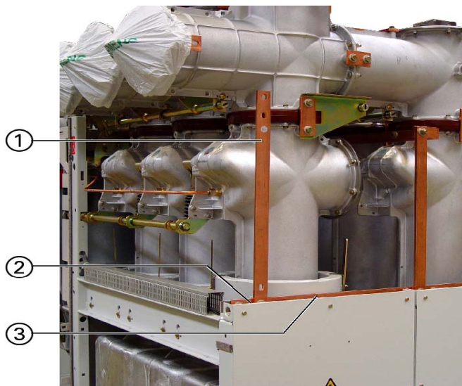
Рисунок 46: Соединение сборных шин заземления винтами
