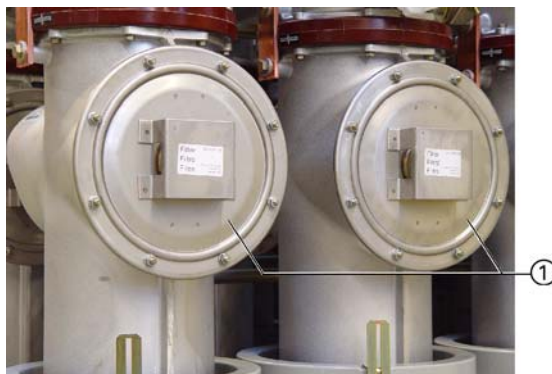
Рисунок 50: Крышка предохранительной мембраны на корпусе силового выключателя
